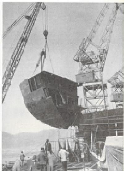
Moderni sistemi costruttivi al Cantone del Mugugno. La poppa prefabbricata del motore «Vicar Sincrostar» del peso di 42 tonnellate, viene sollevata per mezzo del pontone «Atlas» dal piano di stabilizzazione per il montaggio.
